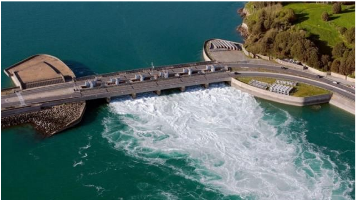
Usine marémotrice de la Rance : une des seules centrale au monde à utiliser l'énergie des marées pour produire de l'électricité
